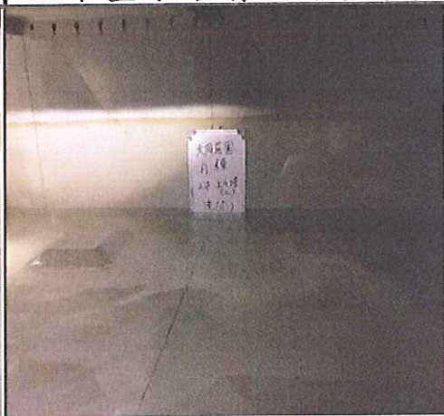
A棟R3F水塔清洗前
