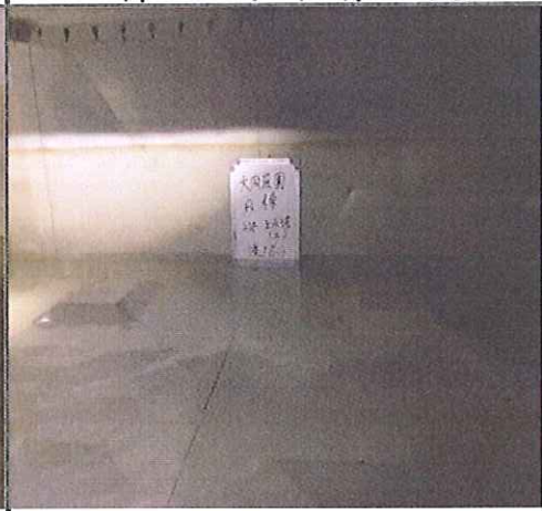
B棟R3F水塔清洗前
