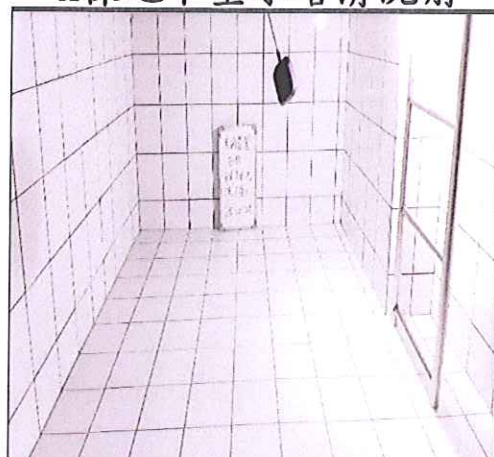
B棟地下室水塔清洗後
