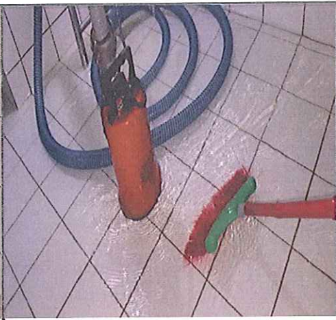
地下室水塔清洗過程(7)
