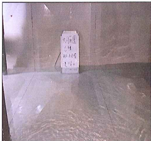
C棟R3F水塔清洗前
