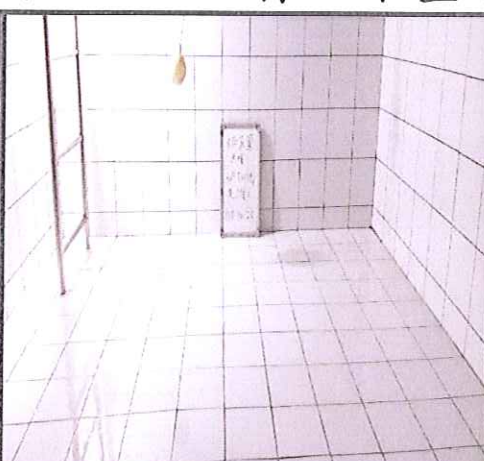
A棟地下室水塔清洗後
