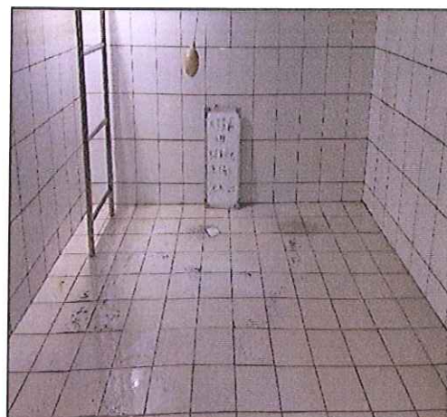
A棟地下室水塔清洗前
