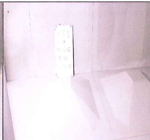
C棟R3F水塔清洗後
