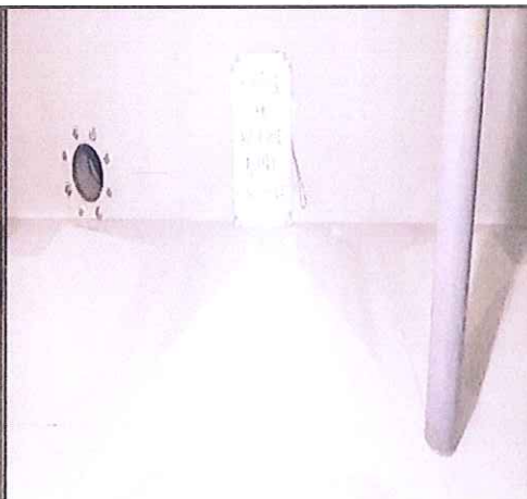
C棟R2F水塔清洗後
