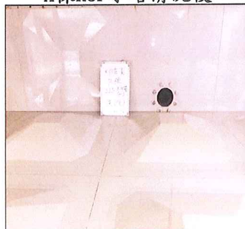
B棟R2F水塔清洗後
