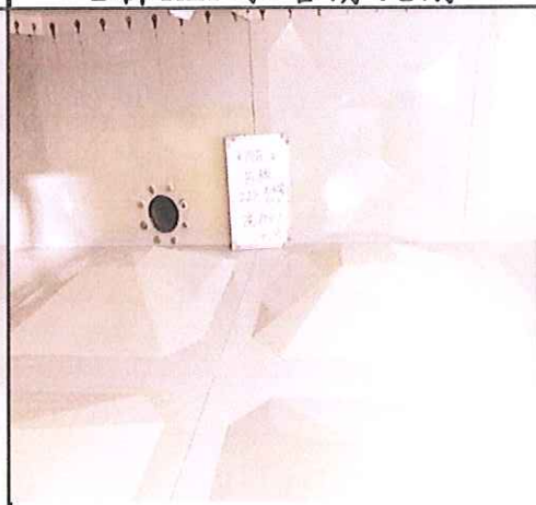
B棟R3F水塔清洗後
