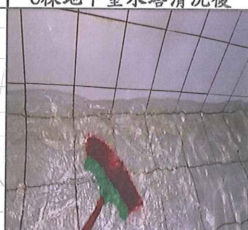
地下室水塔清洗過程(1)
