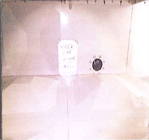
A棟R2F水塔清洗後
