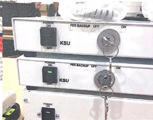
電梯監控主機-火警時連動電梯至地面層
